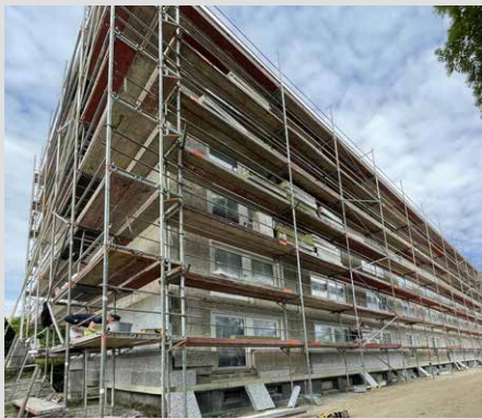
Dämmung wird angebracht
