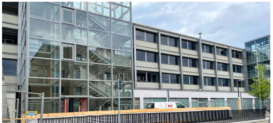
Treppenturm des Laubenganghauses
