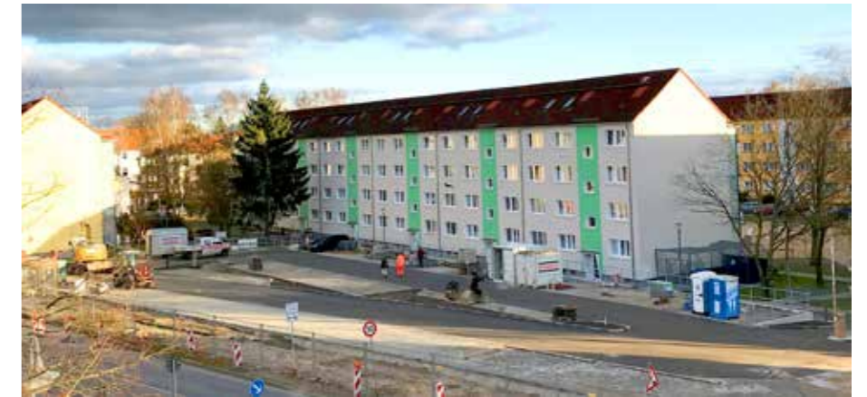
Die Bauarbeiten am Parkplatz Heinersdorfer Straße neigen sich dem Ende.
