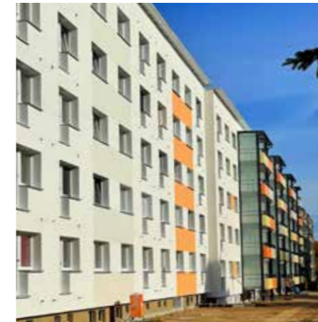
Neue Fassade und Balkone in der Hermann-Duncker-Straße.
