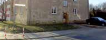
Am Steintor: vor und nach der Sanierung
