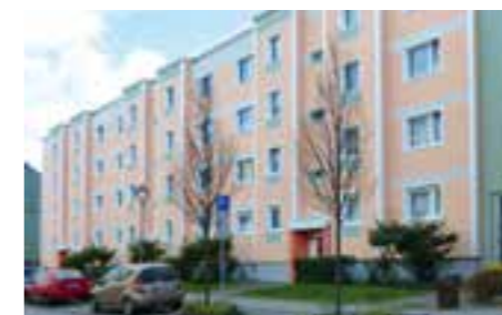
Neue Fassade Berliner Straße
