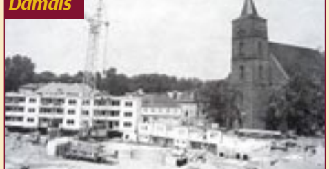
Bauarbeiten an der Mühlenstraße
