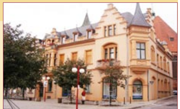
Denkmalgerechte Sanierung der Bürgerhäuser Markt 3 und 5
